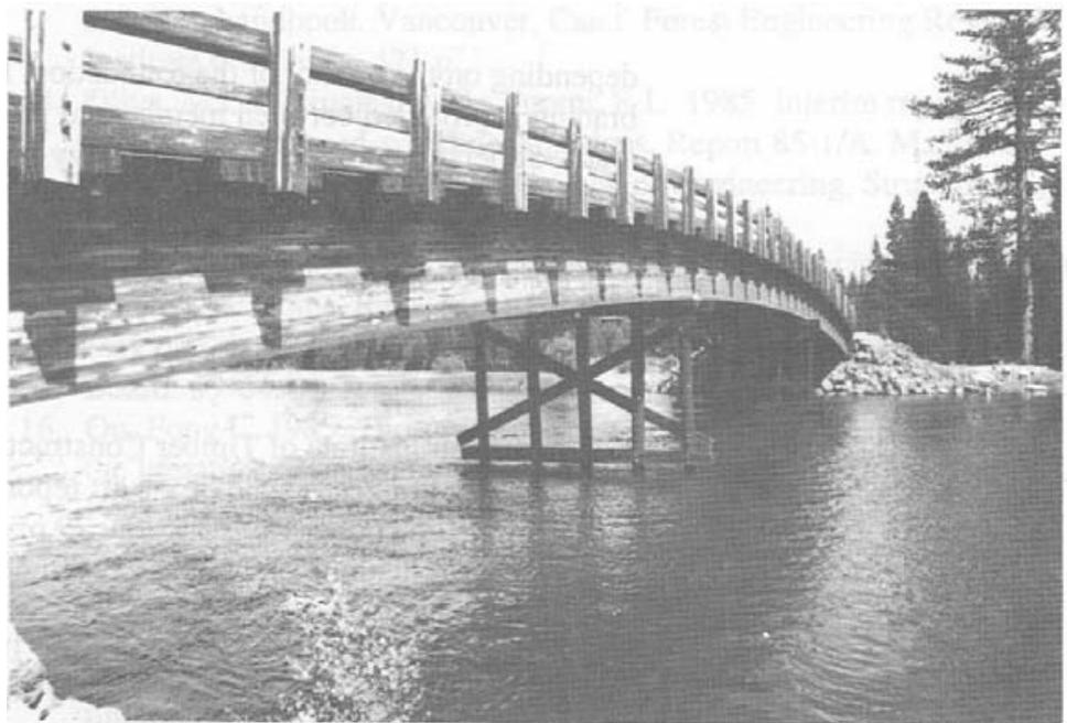
*Figure 2-33.- Timber pile bents.*
